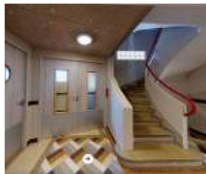
Copro 4 ANCIEN HOPITAL - St Nazaire : rénovation énergétique, toiture ardoise, sécurité incendie et parties communes - 2018/2021
