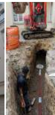
Réfection canalisations enterrées
