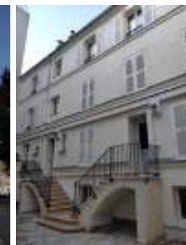
Copropriété - 6 Villa Saint-Jacques 75014 Paris, Réhabilitation lourde ; Ravalement, Correcteur Thermique par l'Extérieur (Béton de Chanvre) - Chantier 2022 / 2023
