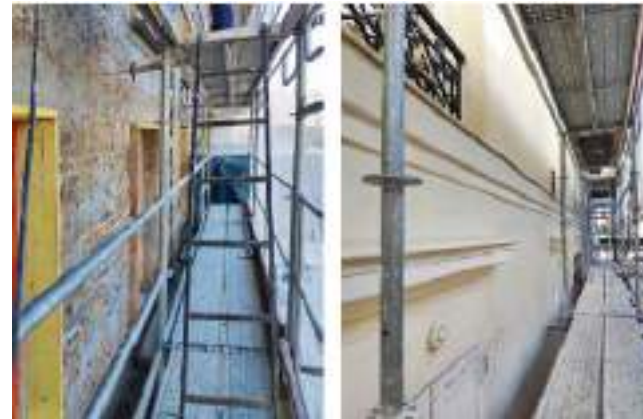
Copropriété 1910 à Saint Denis – Rénovation thermique chaux chanvre en 2020/2021
