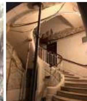
Renforcement structurel - Rue du Chemin Vert à Paris 11 ème - 2023
