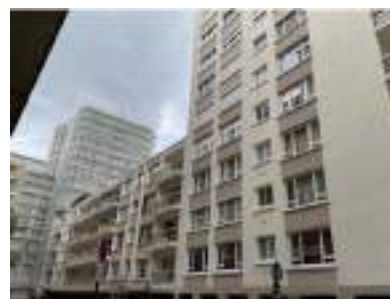
Ravalement et étanchéité des balcons- Immeuble 1950
