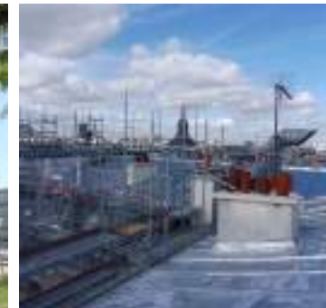
Copropriété du XIX ème à Paris 4 ème - Réfection de la Toiture avec isolation - Travaux 2023
