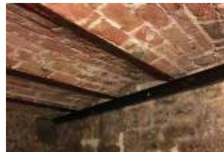
Copropriété 17 avenue Gambetta 75020 Confortement du plancher haut des caves 2022
