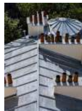
134-136, bd Raspail à Paris 6 ème Réfection d'une couverture en ardoise et zinc en 2023-2024
