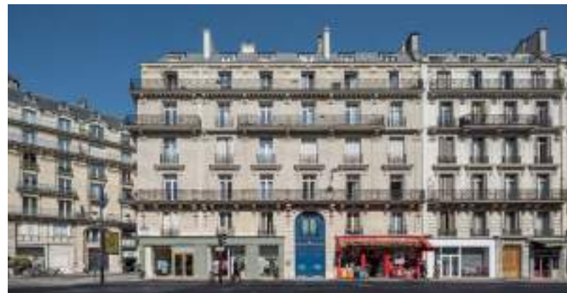
Ravalement d'un immeuble en pierre de taille – Rue de Rennes à Paris 5 ème - 2022
