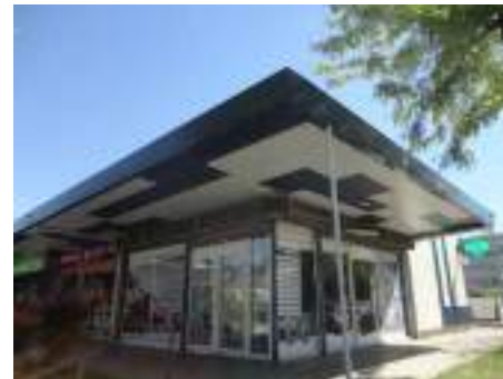
Copropriété commerciale de 1967 à Vaires sur Marne - Réfection de la Toiture (étanchéité 2000 à Paris et bardage) - Travaux 2021
