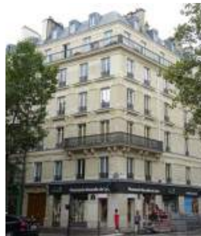
Copropriété rue de Lyon Paris 12 ème - Ravalement
