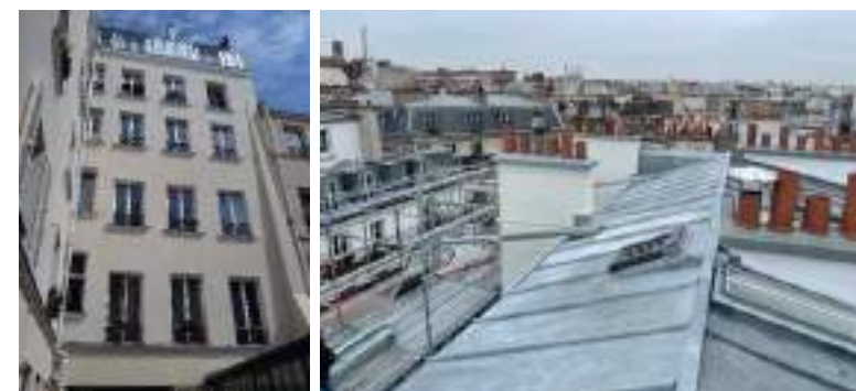
Copropriété du 3 bis rue Bleue 75003 Paris- Ravalement des façade cours en enduit à la chaux avec confortement de la structure en pan de bois et réfection de la couverture en zinc en 2023
