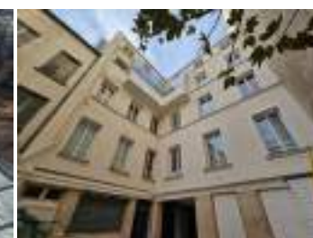
Monopropriété - 38 Rue d'Enghien 75010 Paris, Ravalement de la façade Rue (plâtre-chaux) ; Ravalement des façades Cour avec Isolation Thermique par l'Extérieur (Panneaux en Fibre de Bois), réfection des couvertures en zinc avec Isolation Thermique par l'Extérieur (Isolant mince multicouches) - Chantier 2024 / 2025
