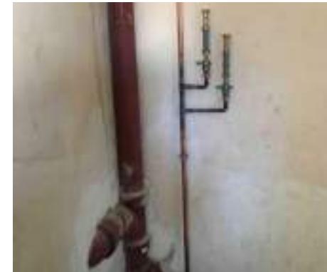
Copropriété 6 rue Dauphine 75006 Remplacement d'une chute d'eaux usées et d'une colonne montante eau froide 2024
