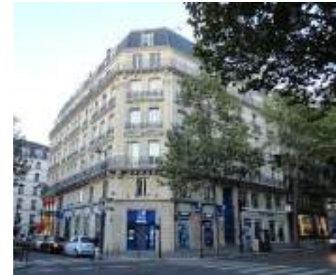
Immeuble Paris 4 ème - Travaux 2023
