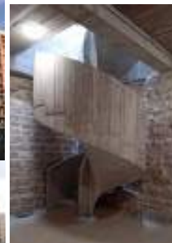
23 rue poissonnière Paris 2e Création d'un escalier en béton
