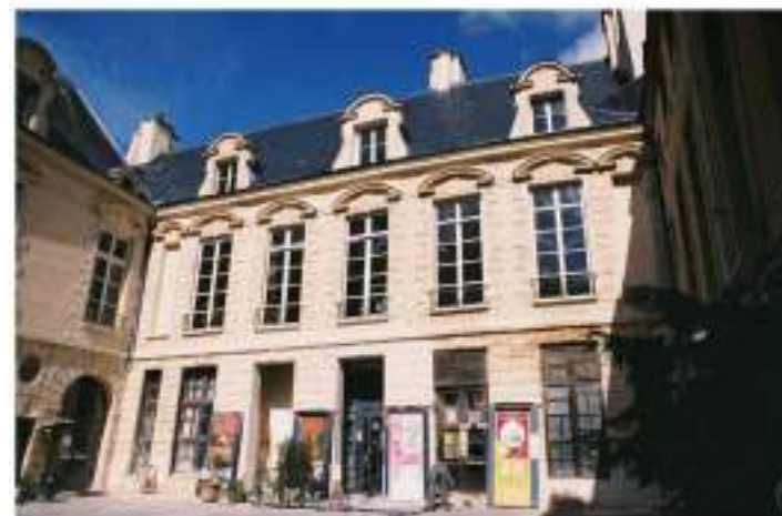
FAÇADE DE FACE DANS LA COUR - APRÈS TRAVAUX DE RESTAURATION
