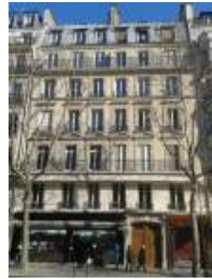
Immeuble Paris 18 ème - Travaux 2022
