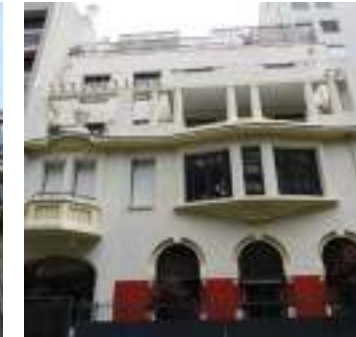
Copropriété de 1926 avec extension de 2002 à Paris 13 ème - Ravalement en 2024
