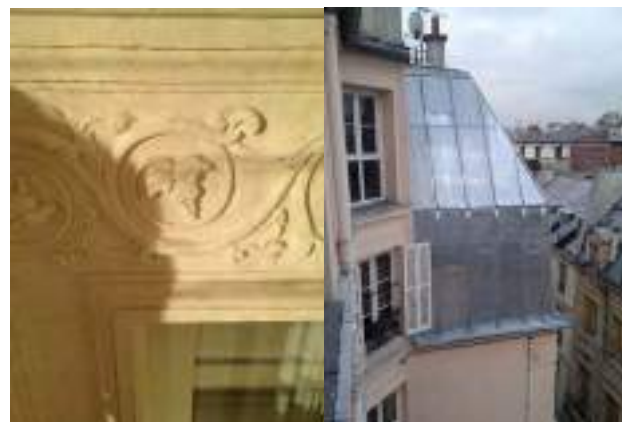
Copropriété du 49 rue Saint Roch à Paris 1 er – Ravalement et Réfection de la couverture en 2013
