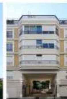
Copropriété du 29-31 rue de Chambéry à Paris 15 ème Ravalement en 2023
