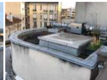
Copropriété du 138 rue du Point du Jour à Boulogne Billancourt Réfection d'étanchéité de toiture-terrasse (étude en cours)
