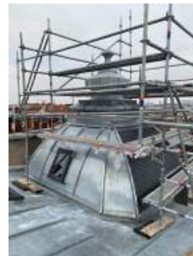
Copropriété à Vincennes Réfection couverture 2024
