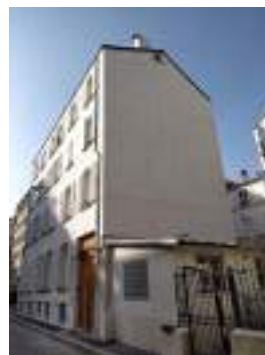
Copropriété - 6 Villa Saint-Jacques 75014 Paris, Réhabilitation lourde ; Ravalement, Correcteur Thermique par l'Extérieur (Béton de Chanvre) - Chantier 2022 / 2023
