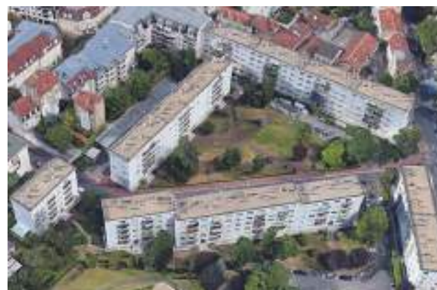
FONCIA 5 Immeubles année 60 166 logements DTG
