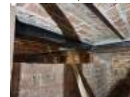
33 rue de la Chine 75020 Confortation plancher (2022)
