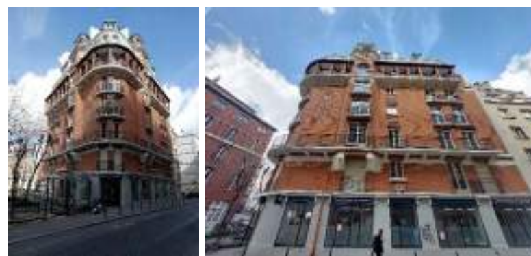
Propriété du 66, rue Falguière 75015 Paris- Ravalement de la façade en brique et réfection de la couverture en zinc en 2023
