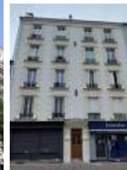
Immeuble 5, rue Béranger à Malakoff / Ravalement
