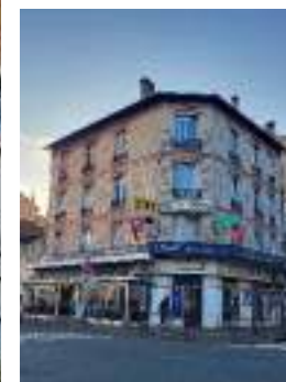
Maisons-Alfort- rénovation couverture –en cours
