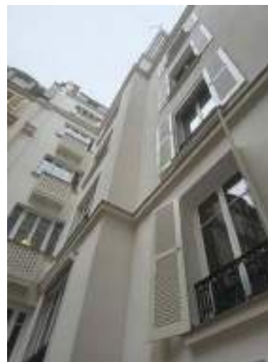
Copropriété rue Rocroy Paris Ravalement façades cour 2025
