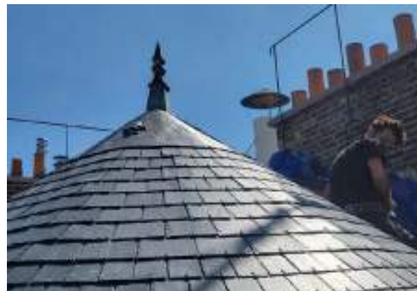
Copropriété du 4, ave Sully Prudhomme à Paris 7 e Réfection couverture en 2025
