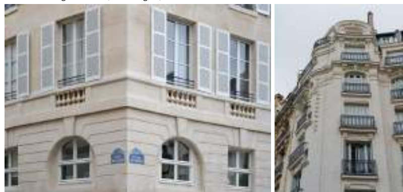
Ravalements de façades pierre. Place de l'Odéon, Avenue du Général Détrie.
