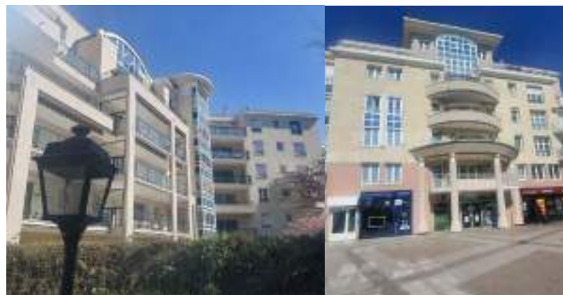
Résidence Clémencia à Sceaux – Ravalement et ITE en cours
