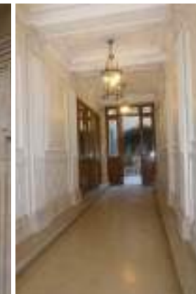
Rénovation porche d'entrée
