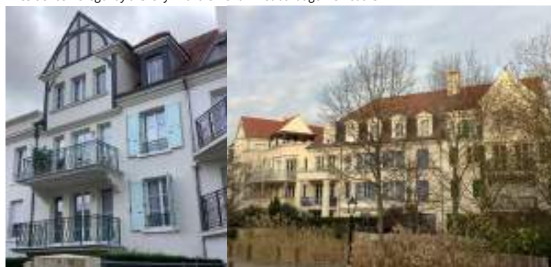
Résidence Victoria au Plessis-Robinson – Ravalement ITE en cours
