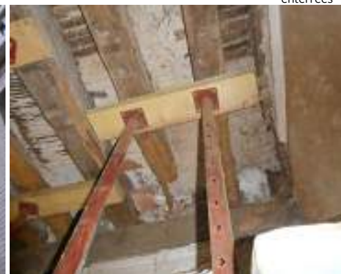
Remplacement solives plancher bois dans logement
