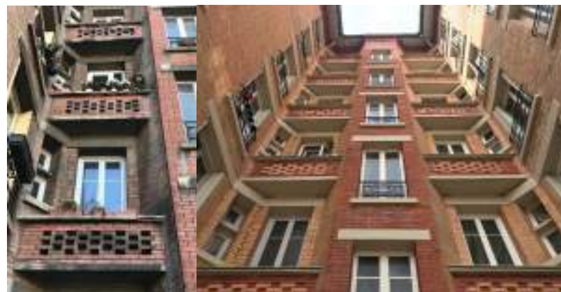
Copropriété à Ivry-sur-Seine, 94200 – Ravalement des façades sur cour
