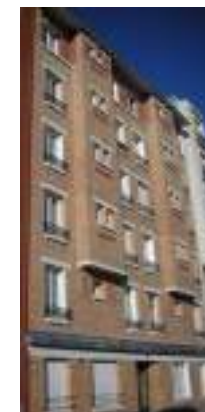
94, Maurice Arnould à Montrouge Ravalement
