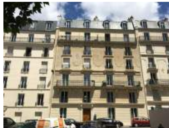
SDC. 51 rue Bargue à Paris 15 ème MOA Cabinet JFT. Ravalement en 2016/2017
