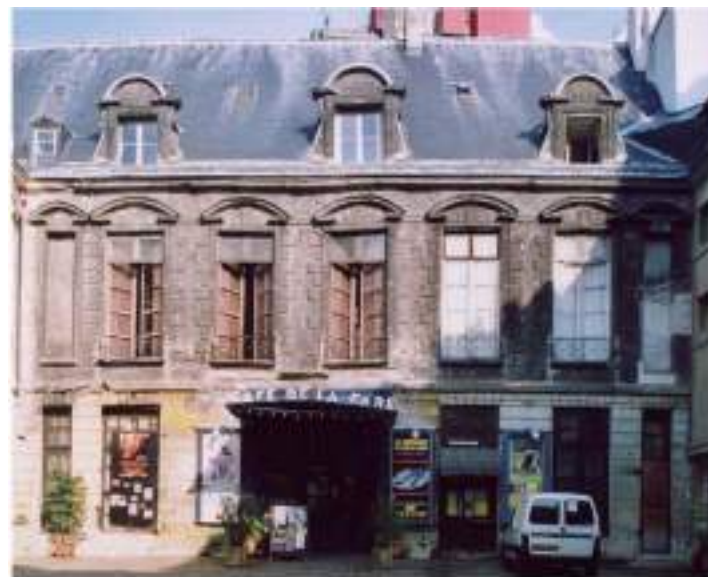
FAÇADE DE FACE DANS LA COUR - AVANT TRAVAUX DE RESTAURATION
