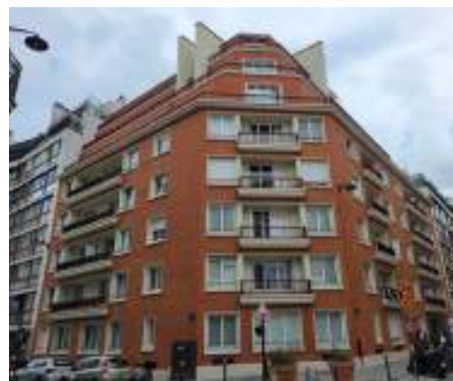
Copropriété du 12bis Val de Grâce Paris 5 ème Ravalement + étanchéité loggias et terrasses en 2024
