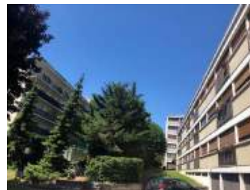
Copropriété à Maisons-Alfort (94) : SDC : Syndic ADB Patrimoine Rénovation de toiture pour 4 immeubles d'habitation en copropriété P123
