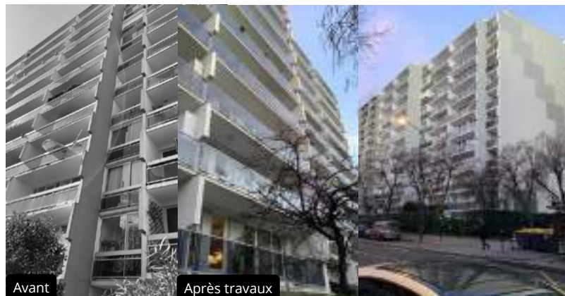
Résidence Bérégovoy à Clichy - Ravalement ITE et bardage – en cours
