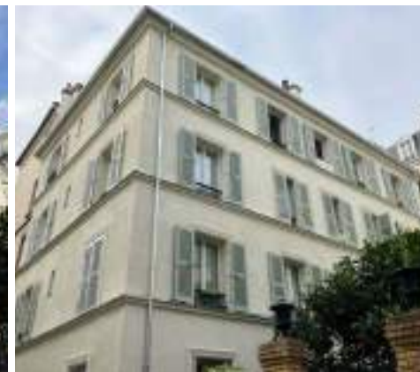
Ravalement avec Isolation Thermique et restitution des modénatures – rue des Thermopyles - 75013
