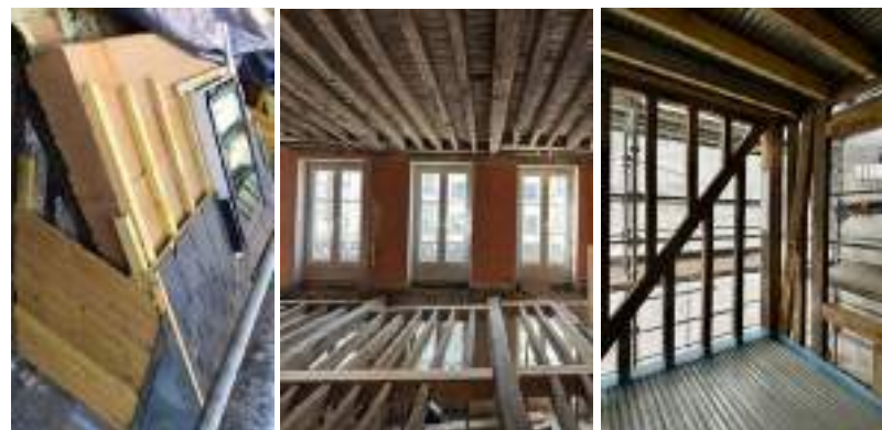
Isolation de couverture par l'extérieur, structure de planchers et pans de bois Avenue du Général Foy, rue de Liège
