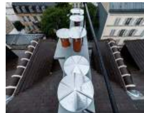
33, rue Vaneau à Paris 7 ème Réfection d'une couverture en tuiles du Marais et zinc en 2025
