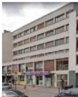
Juvisy- DTG 2023 Rénovation énergétique en cours
