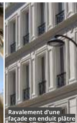
Ravalement et protection des reliefs
