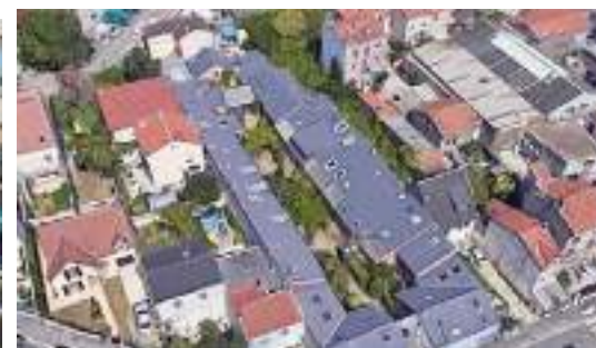
Bagnolet – copropriété de maisons autour d'une cour DTG 2023 – Rénovation couverture en cours
