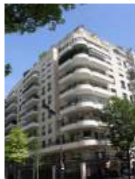
Copropriété Palais de Seine à Levallois Ravalement des façades
