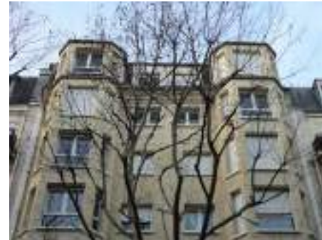
Copropriété de 2000 à Paris 20 ème - Travaux de ravalement structure béton et parement pierre - Travaux 2019
