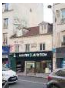
Paris XX rue de Belleville- DTG 2023/24- Rénovation énergétique en cours
