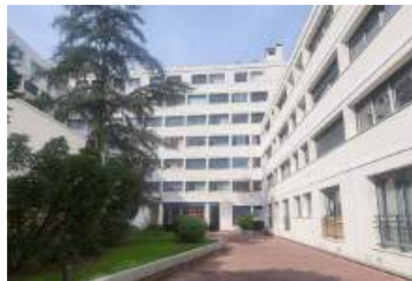
Copropriété du 80-84, rue Baudin à Levallois-Perret Rénovation thermique en 2023/2024
