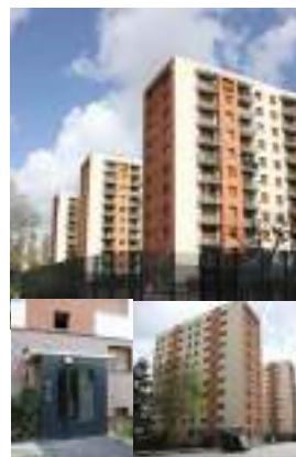
Résidence La Bruyère à Bondy Rénovation globale
