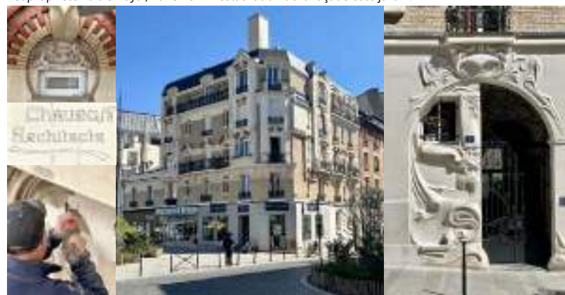
Copropriété locative (bailleurs), Paris 7e – Réfection des canalisations et remise en état du sous-sol.
