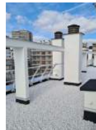
Copropriété du 10 rue Henri Becque à Paris 13 ème Réfection étanchéité toiture-terrasse (2024)
