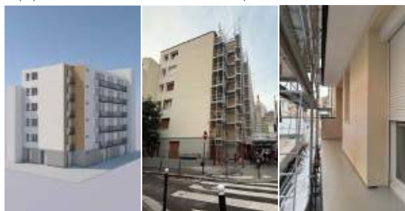
Rénovation énergétique du 27 rue Charles Fourier, de l'étude au chantier 2023 à 2026
