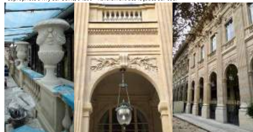
Copropriété Palais Royal, Paris 1er – Restauration de la façade côté jardin.
