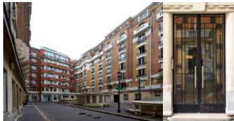
Copropriété 4-8 Square Delormel– Paris 14 Conception en Rénovation énergétique en cours*
