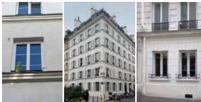
Ravalements chaux, suppression de devanture commerciale et recréation de façade en rez-de-chaussée Rue du Faubourg Montmartre, rue Martignac, rue Alexandre Dumas.
