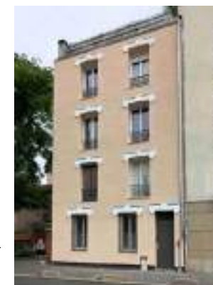
Copropriété du 48 rue Raspail à Montreuil - Ravalement avec ITE en 2024
