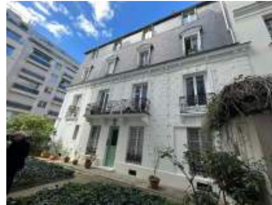
Copropriété rue Falguière 75015 PARIS Ravalement 2024
