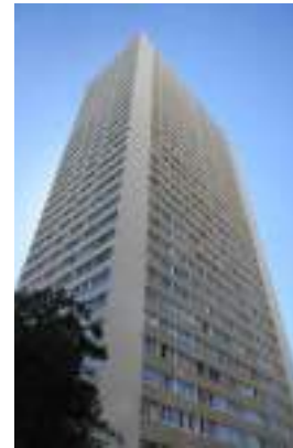
Tour Bologne IGH, Paris 13 ème - 2018 Ravalement avec ITE en présence d'amiante
