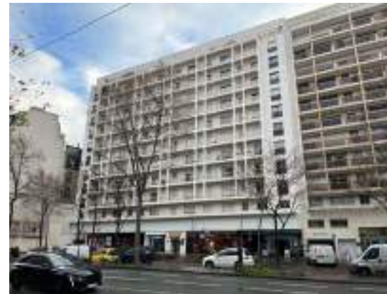
SDC 93-95 avenue du Général Leclerc à Paris 14 ème – MOA Cabinet Jourdan. Ravalement en 2022/2026
