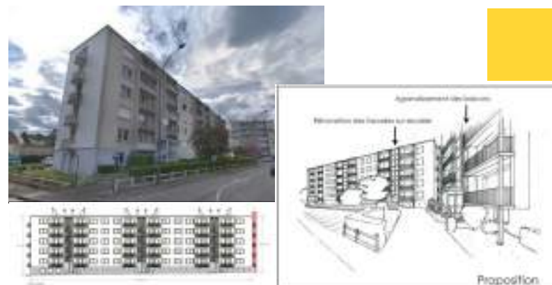
Copropriété des Alysse à Massy (91) - 56 logements
