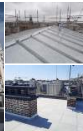
Etanchéité toit terrasse + garde-corps
