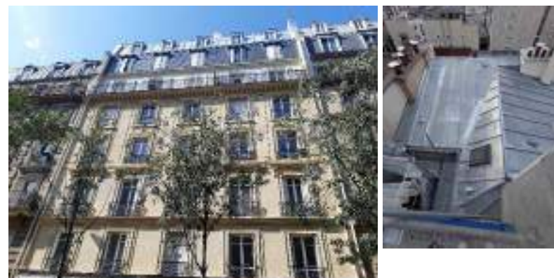
Copropriété du 131 Avenue Parmentier 75011 Paris- Ravalement de la façade en pierre et réfection de la couverture en ardoise et zinc en 2021
