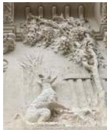
Copropriété du 31, rue Kléber à Issy-les-Moulineaux Rénovation pierre en 2025
