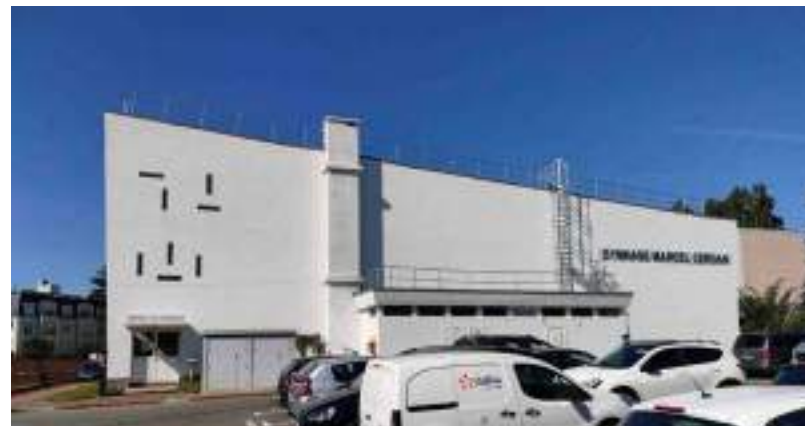
Gymnase M. Cerdan à Gagny (93) : Ravalement ITE fibre de bois + réfection et isolation toiture - 2020
