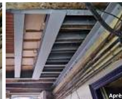
Copropriété rue Rochechouart Paris 9 ème - Reprises structurelles de planchers
