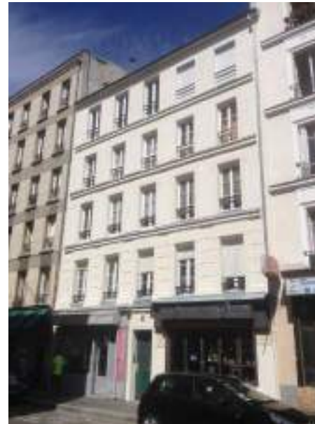
Copropriété 3 rue de Tlemcen 75020 Ravalement rue
