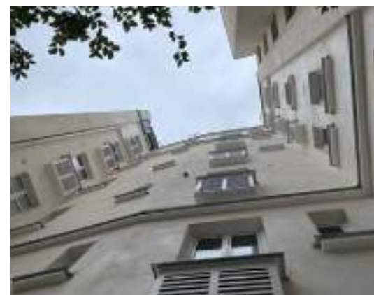
Copropriété du 8 rue de la Chine à Paris 20 ème - Ravalement en chanvre et chaux d'une courrette et de pignons mitoyens
