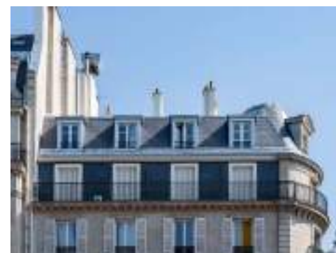
134-136, bd Raspail à Paris 6 ème Réfection d'une couverture en ardoise et zinc en 2023-2024
