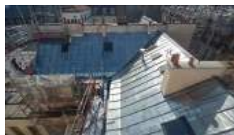
Monopropriété - 38 Rue d'Enghien 75010 Paris, Ravalement de la façade Rue (plâtre-chaux) ; Ravalement des façades Cour avec Isolation Thermique par l'Extérieur (Panneaux en Fibre de Bois), réfection des couvertures en zinc avec Isolation Thermique par l'Extérieur (Isolant mince multicouches) - Chantier 2024 / 2025
