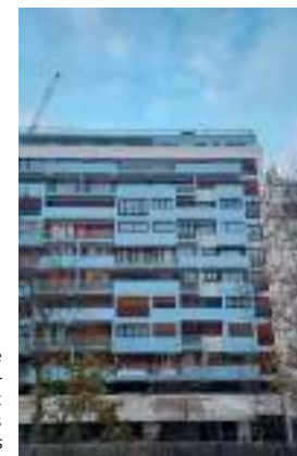
Copropriété du 86 avenue Daumesnil à Paris 12 ème - Ravalement avec renforcement des balcons et isolation des pignons
