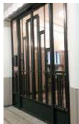
Création porte de sas
