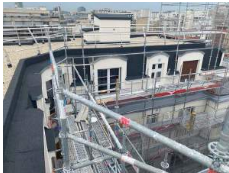
Copropriété rue J.Mawas Paris Travaux de réfection étanchéité toiture terrasse et ravalement des façades 2025
