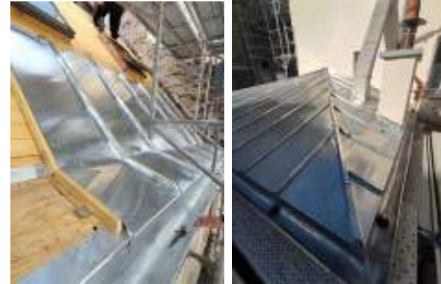
Copropriété du 10 rue Germain Pilon PARIS 18 - Couverture zinc à tasseaux et isolation thermique en 2023-2024
