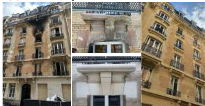
Copropriété du 9 rue Cadix à Paris 15 ème – Ravalement 2024 par suite d'incendie.
