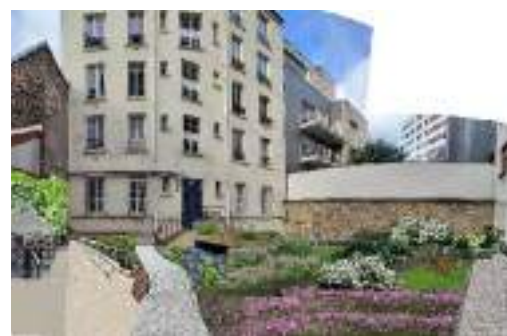
Paris XII- Aménagement cours d'immeuble Dispositif CoproOasis- en cours
